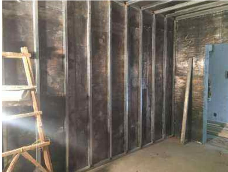
射线也是一种电磁波，但是波长比较短，穿透能力比较强，这种穿透的容易度，跟物质的密度有关，铅板的密度很高，而空气的密度很低，所以铅板可以完全阻隔X光，而空气则毫无阻挡能力。X射线对人体有伤害作用。我们的防护可以采取屏蔽防护和距离防护原则。屏蔽防护是指使用原子序数较高的物质，常用铅或含铅（单质）的物质，作为屏障以吸收不必要的x线。距离防护是指利用x线曝射量与距离平方成反比这一原理，通过增加x线源与人体间距离以减少曝射量。X光对各种物质的穿透力不一样。使用高密度钡水泥（就是含\*\*\*钡的水泥）也可以一定程度地屏蔽X射线。铅板(Pb)阻挡X射线的性质实质上不是一般的物理或者化学性质，而是原子物理学的概念，是对于电磁波的阻挡原理。
